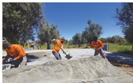
» Preparação do terreno.
