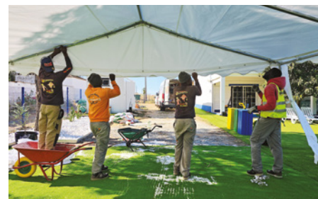
» Montagem de estruturas.
