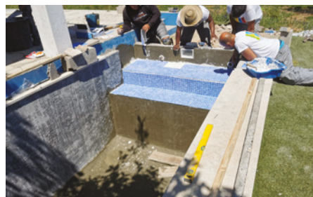
» Construção de piscinas.
